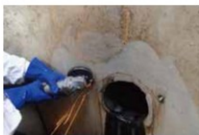
②バッフル板のアンカーを切断します。
