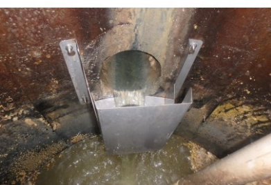
⑤汚水受けの取付。
