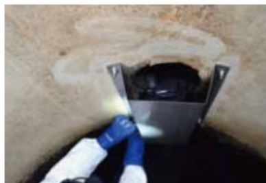
①既設のバッフル板を撤去。
