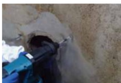
④アンカー打ちつけ。 (M10 前後のアンカーボルト)
