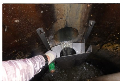
③汚水受けのアンカー取付位置を墨出し。
