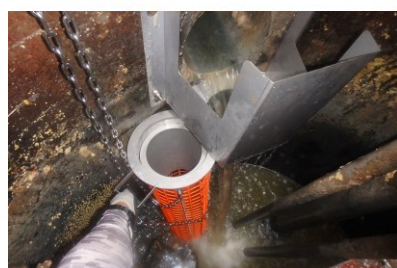
⑥カートリッジに絞り管をはめ込み汚水受けに差し込む。
