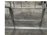
③ 上段にもバーを差し込み出入口柵の設置は完了です。
