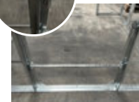
② 出入口柵の下端差し込み口にバーを差し込みます。
