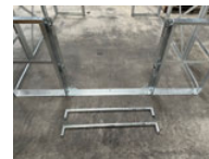
① まずは出入口柵を設置します。
