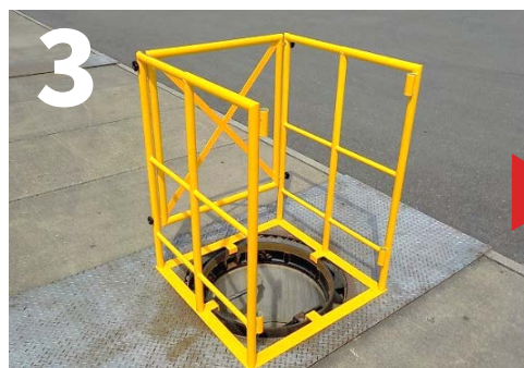
柵①、柵②を土台に立てる
