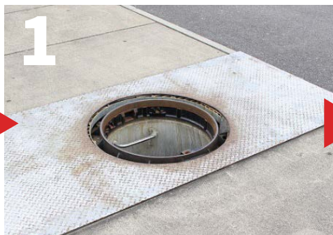
マンホールの蓋を外す
