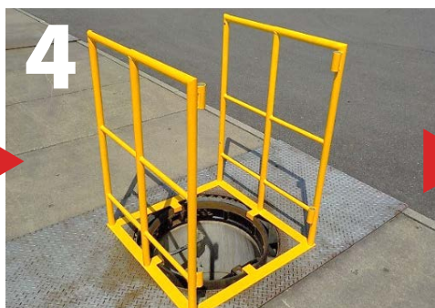
クロス柵をボルトで 4カ所を固定
